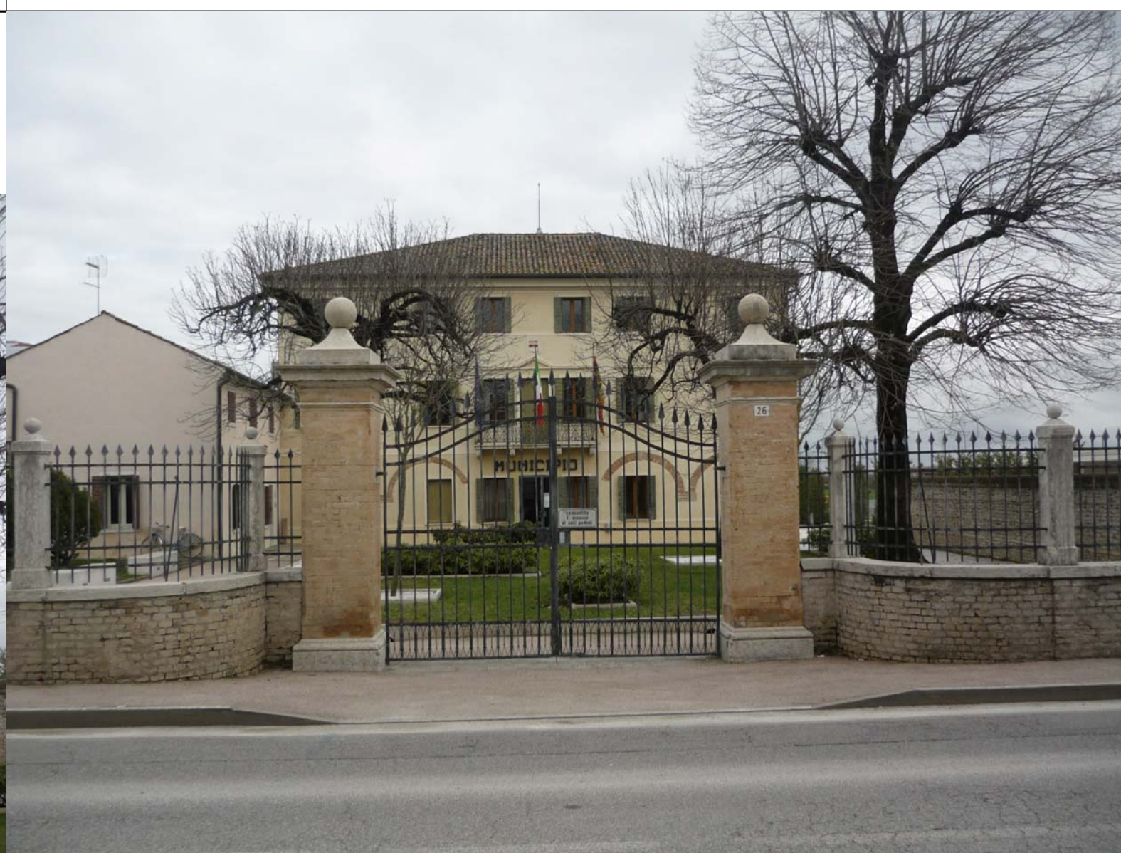
FOTOGRAFIA 3 PROSPETTO SUD: da via S. Daniele
