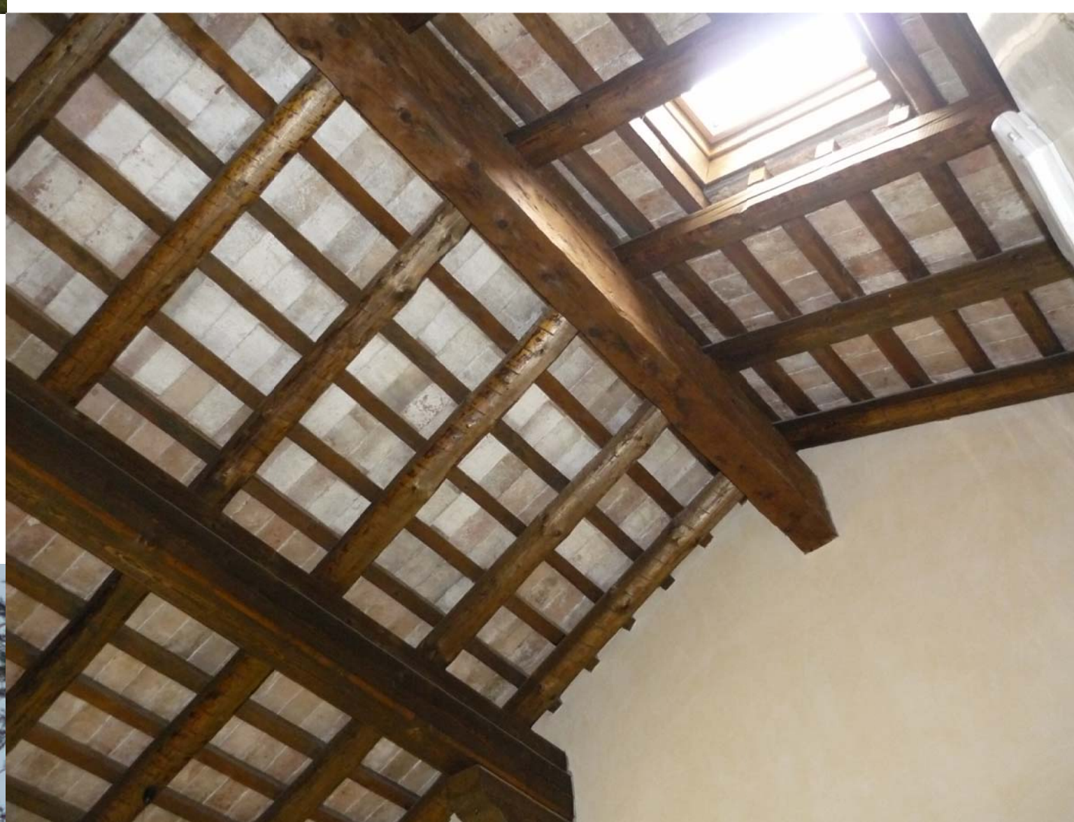
FOTOGRAFIA 4 DETTAGLIO STRUTTURE LIGNEE DI COPERTURA
